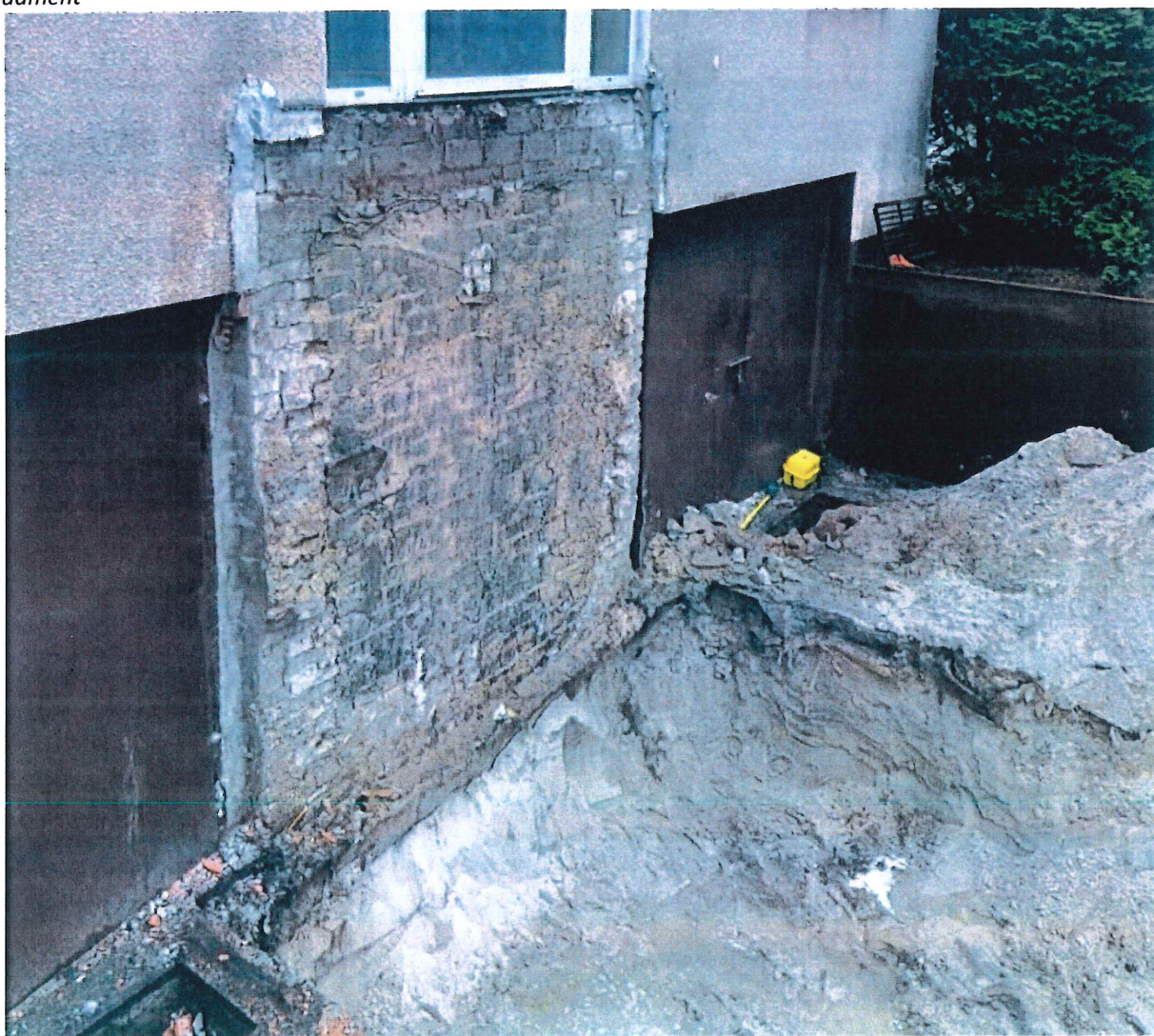
Fot. 14. Ściana szczytowa od strony zachodniej (zdjęcie archiwalne) - widoczny materiał oraz odsłonięty fundament
