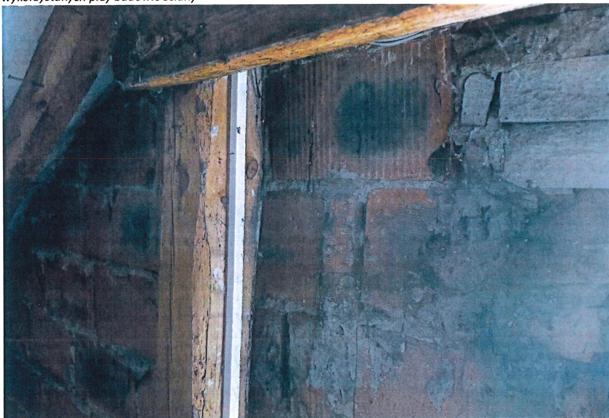
Fot. 11. Nieotynkowany fragment ściany szczytowej na poddaszu - widoczne nagromadzenie różnych materiałów wykorzystanych przy budowie ściany
