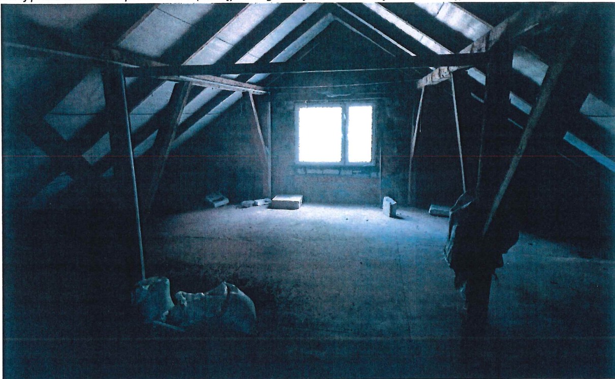
Fot. 1. Poddasze nieużytkowe - widoczne główne więzary płatwiowo kleszczowe. Brak zabezpieczenia folii dachowej przed działaniem promieni UV (nastąpiła degradacja właściwości folii dachowej)
