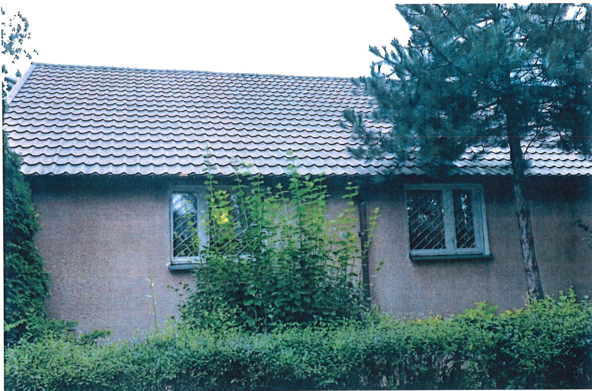
Fot. 6. Widok na budynek od strony południowej. Mały okap dachu powoduje zamakanie elewacji podczas zacinających deszczów
