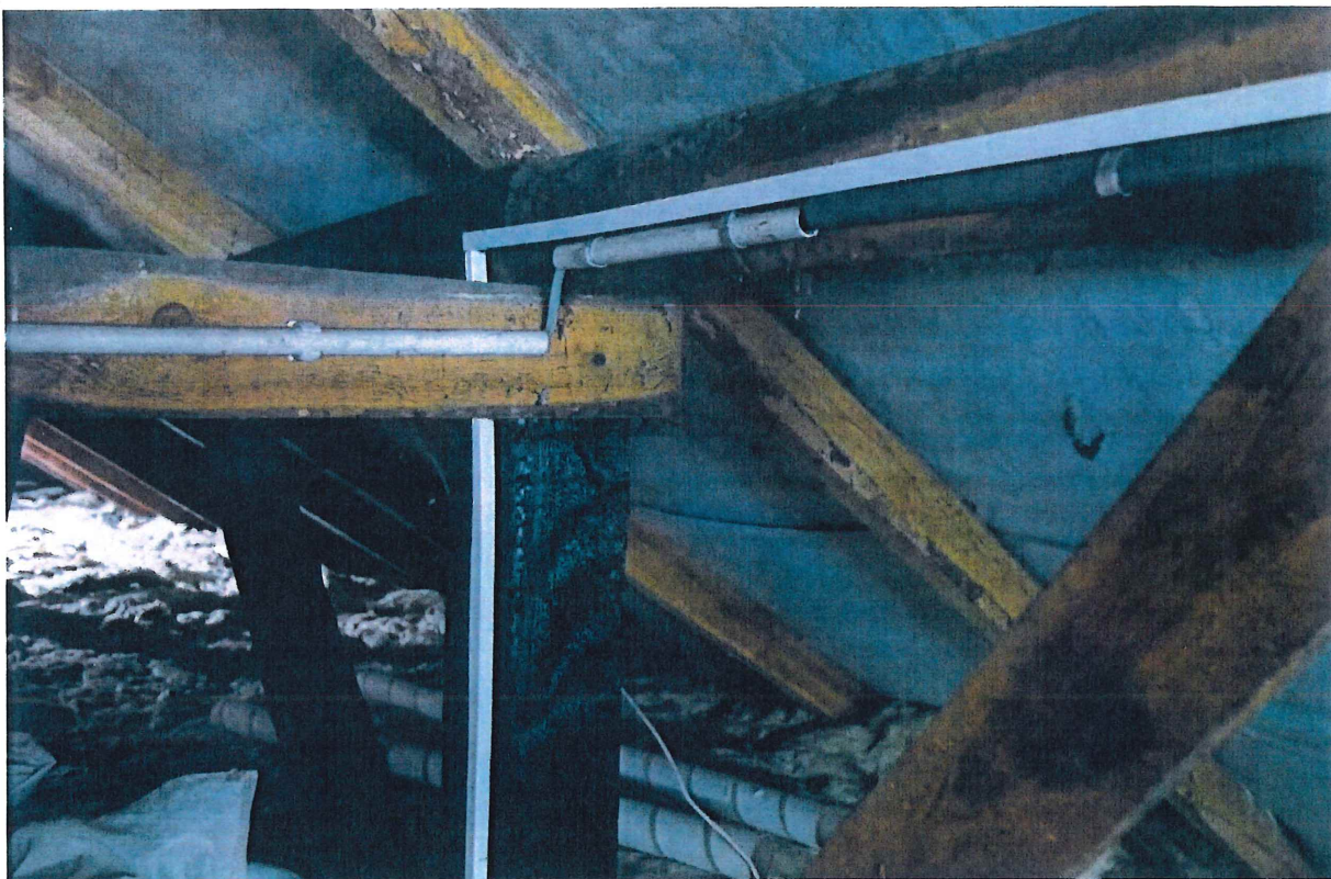
Fot. 3. Fragment konstrukcji więźby - uszkodzenia przez działanie ognia, lokalnie występuje kora na elementach krokwi
