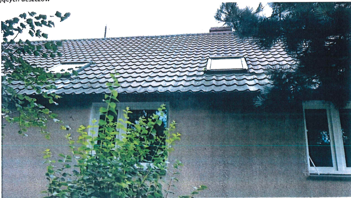
Fot. 6. Widok na budynek od strony południowej. Mały okap dachu powoduje zamakanie elewacji podczas zacinających deszczów
