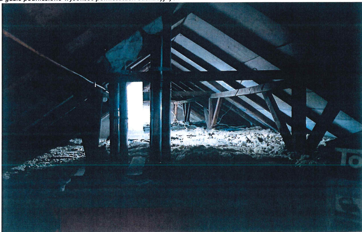
Fot. 2. Poddasze i konstrukcja dachu. Brak ciągłości folii dachowej. Widoczne warstwy wełny mineralnej w miejscu gdzie podniesiono wysokość pomieszczeń edukacyjnych
